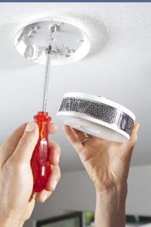
Rauchmelder lassen sich normalerweise mit wenigen Schrauben und Dübeln, die dem Gerät beiliegen, montieren. Die benötigten Löcher gemäß beiliegender Montage-Anleitung in die Decke bohren, Dübel setzen und den Rauchmelder festschrauben. Daneben besteht - je nach Hersteller - alternativ auch eine Befestigungsmöglichkeit mit Klebe- oder Magnetpads.
